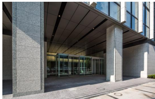
(エントランス外観)
